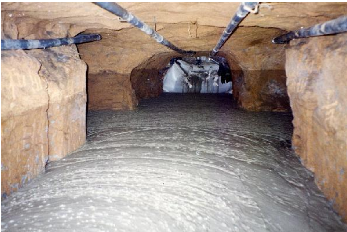
Слика 5: Заполнување на откопите
