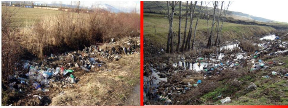
Со затрупување на одводните канали се губи нивната функција.
